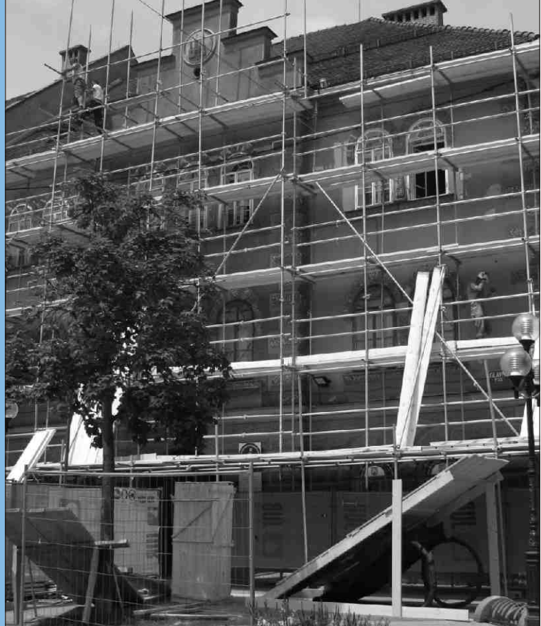
▲ Začetek obnovitvenih del Koroške galerije likovnih umetnosti in Koroškega pokrajinskega muzeja, Slovenj Gradec, junij 2010
